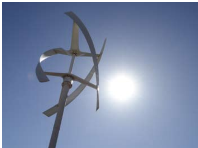
Microgenerador eólico urbano en la ciudad de Málaga (Barrio de La Misericordia).
