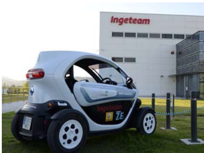
Sede de Ingeteam en Sarriguren (Navarra).
